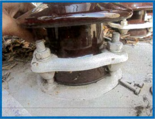
บุชชิงแรงสูง เฟส A,B ลึก
