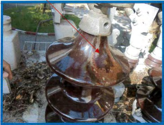
บุชชิงแรงสูง เฟส A,B ลึก
